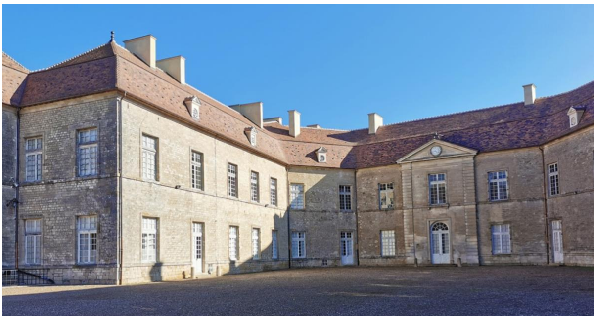
Château de Ray-sur-Saône (propriété du département de Haute-Saône)
